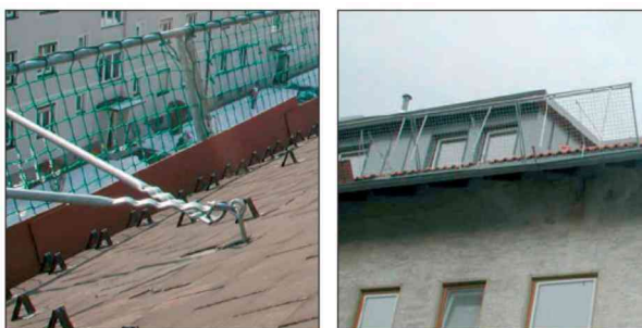
Obrázek 35: Jištění při práci na střeše (AUVA)
