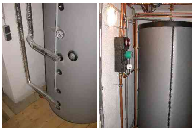
Obr.6.3: Vlevo: Připojení solárního výměníku na teplou vodu ve spodní části zásobníku prostřednictvím solárního okruhu.
