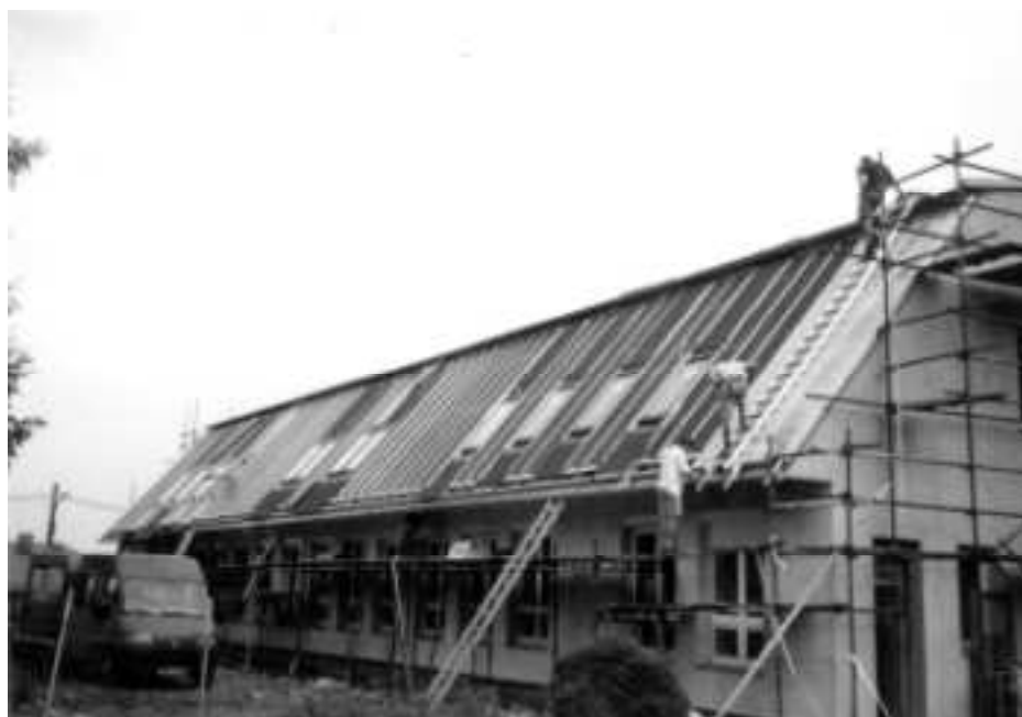
Snímek z montáže kolektoru.
