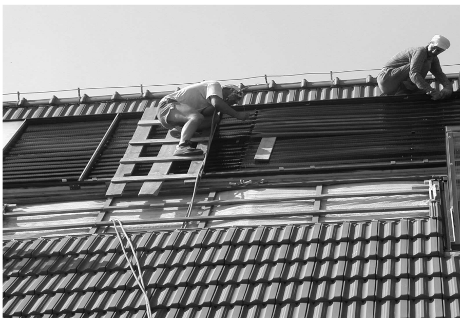
Instalace kolektoru na moštárně v Hostětíně
