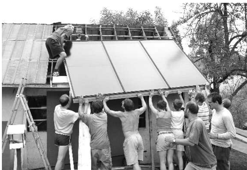
Vynášení smontovaného kolektoru v Českých Budějovicích na střechu objektu
