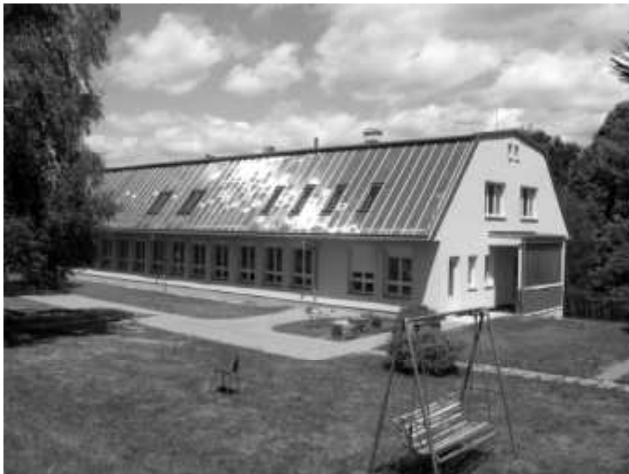
Drain-back systém, celostřešní kolektory
