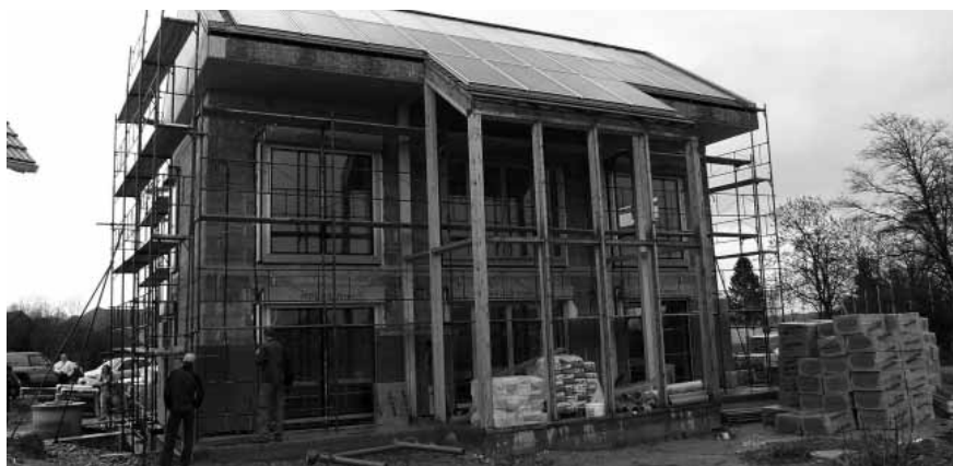
Stavba pasivního domu.
