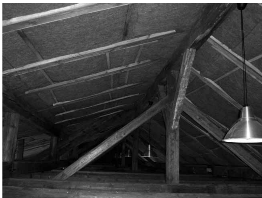
Energetickou náročnost českých budov lze snížit o 60 % (hlavně izolací domů), což odpovídá šestinásobku elektřiny, kterou by dodávalo rozšíření severočeských uhelných dolů pod sousední obce. Na obrázku zateplování přírodním izolací z konopí. foto: Linda Klvaňová, Konopa
